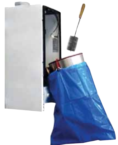
Servisná poloha 2: Čistenie výmenníka kefou, upevnený vak na nečistoty (príslušenstvo)
